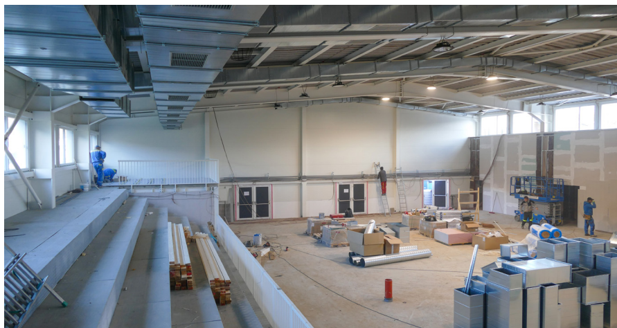
Foto z výstavby multifunkčnej haly
